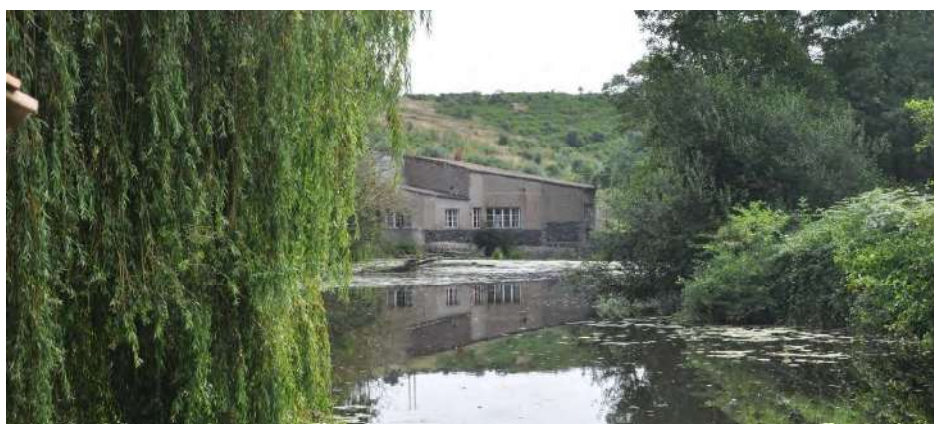
Vue sur l'Argenton, à Argenton-les-Vallées
